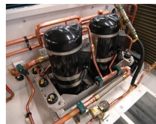
6.3.7. ábra. Párhuzamosan kötött kompresszorok
